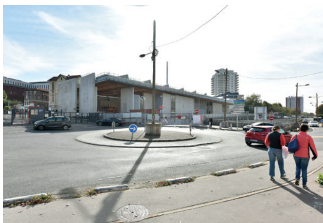
Gare du Grand Paris Express en cours de construction (octobre 2023)
