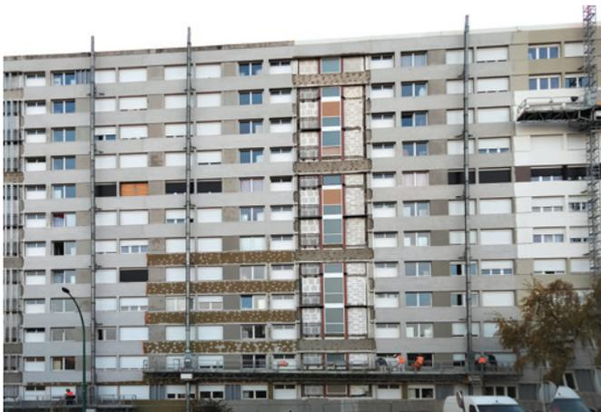
Réalisation d'isolation thermique extérieure dans le cadre de la réhabilitation d'immeubles de logement
