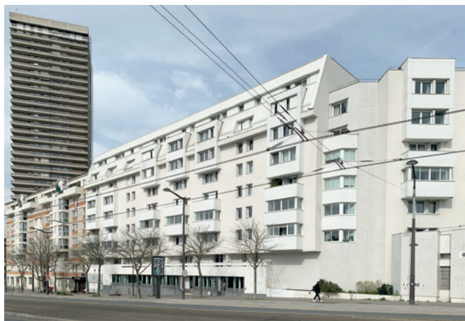
Rénovation énergétique d'un ensemble d'immeubles de logements construits dans les années 80 et situés boulevard Kellermann
