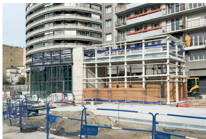
Chantier de construction de la nouvelle gare Maison Blanche donnant sur l'avenue d'Italie
