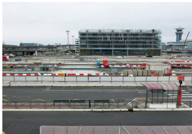
Nouveaux aménagements et parking réalisé à proximité de la future gare
