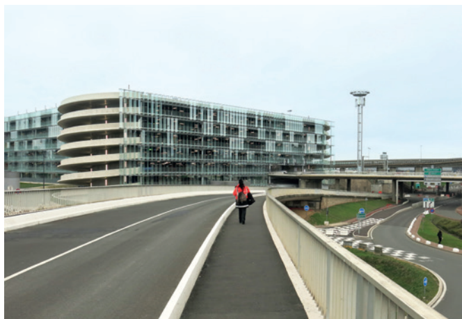
Nouveau parking silo réalisé à proximité de la future gare
