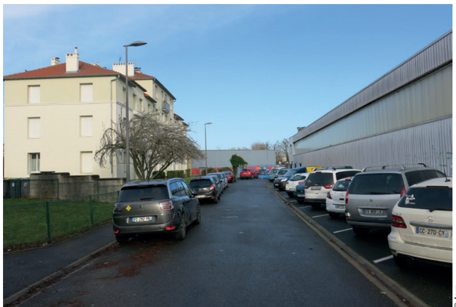
Un entrepôt logistique en limite de la cité-jardin Le Nouveau Logis
