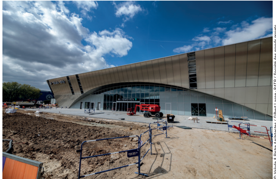
Chantier de construction de la future gare, vue depuis le parvis
