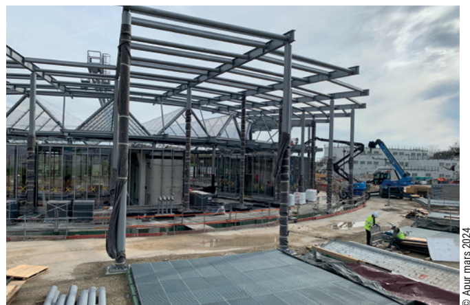
Chantier de construction de la nouvelle gare Villejuif-Gustave Roussy en mars 2024
