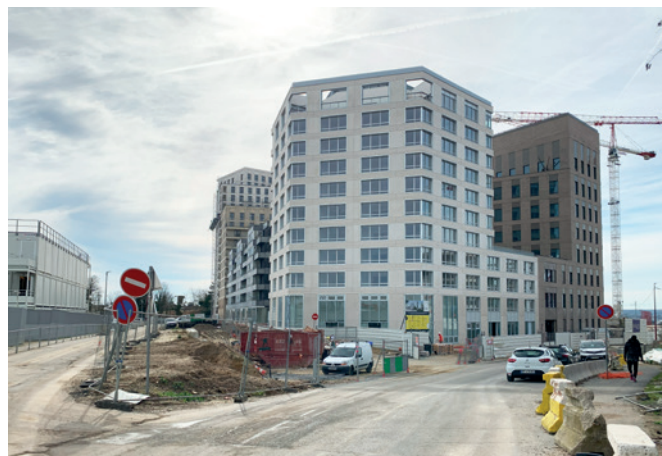
Immeubles de logements collectifs en cours de construction dans la ZAC Campus Grand Parc à Villejuif
