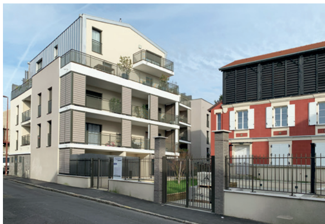
Construction neuve et réhabilitation d'un ensemble de logements collectifs dans le diffus à Cachan
